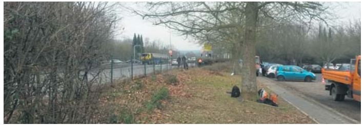
Damit die gefürchteten Staus an der Conti-Kreuzung in Zukunft ausbleiben, soll in den Sommerferien eine neue, längere Rechtsabbiegerspur in der Sodener Straße gebaut werden. Dazu wurde Ende Februar das Buschwerk am Straßenrand gerodet. Foto: mag
