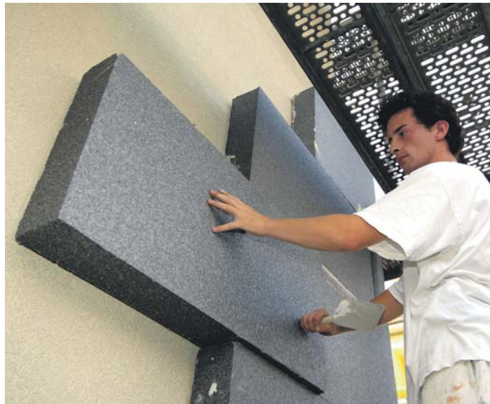
Erst planen, dann sanieren: Die Zuschüsse für eine unabhängige Energieberatung haben sich fast verdoppelt. Daher sollte sich jeder vor Beginn einer Dämm-Maßnahme informieren. Foto: djd/IVH
