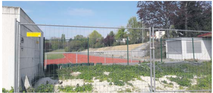
Hinterm Bauzaun ruhen zurzeit die Arbeiten an der neuen Tribüne. Und auch Sportler werden auf der Anlage in der Wilhelm-Leuschner-Straße im Moment allenfalls geduldet. Foto: Schlosser
