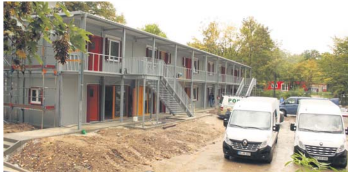
Noch herrscht an der Flüchtlingsunterkunft Baustellenbetrieb. Obwohl das Gebäude noch nicht ganz fertig ist, sollen die Flüchtlinge aus den Zelten in der kommenden Woche einziehen. Foto: Schlosser
