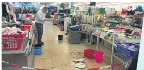
Wegen des Wasserschadens war Anfang der Woche ein Teil des Rhein-Main-Kaufhauses am Marktplatz gesperrt. Foto:privat
