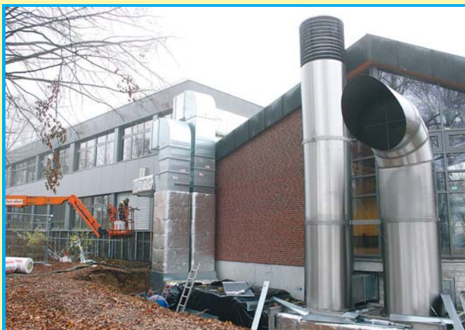
Großer Aufwand. Mit großem Aufwand ist das Atrium am Westring in den vergangenen anderthalb Jahren saniert worden. Alle Fenster wurden ausgetauscht und eine gewaltige Lüftungsanlage durchzieht jetzt das ganze Gebäude. Mehr zu dem 2,7 Millionen Euro teuren Umbau des ehemaligen Schulgebäudes lesen Sie auf Seite 6. Foto: Schlosser
