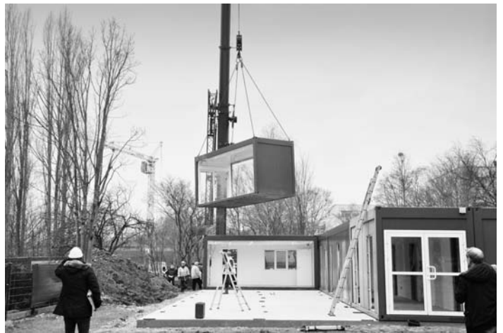
Per Kran schwebten in der vergangenen Woche die Container für den Behelfskindergarten auf den Platz des ehemaligen Kitageländes in der Frankenstraße ein. Foto: mag
