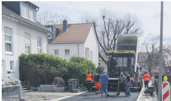
Nur noch ein paar Schönheitsreparaturen stehen „Am Sandring“ noch aus. Dann ist der erste Bauabschnitt fertig. Im Herbst wird der Rest der Straße saniert. Foto: mag
