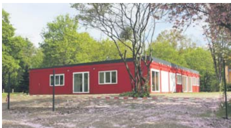
In knallroten Containern sind die Kinder in der neuen Kita in der Frankenstraße untergebracht. Foto: Schlosser
