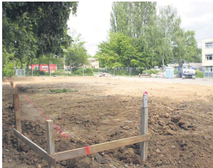
Seit vergangener Woche rollen auf dem ehemaligen Schulhof die Bagger.
