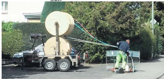
9,1 Kilometer Glasfaserkabel wurden in Schwalbach verlegt.
