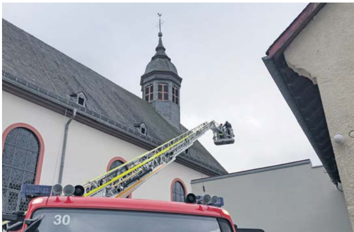
Feuerwehr hilft. Die Schwalbacher Feuerwehr leistete beim Austausch defekter Dachschindeln auf dem Kirchendach von St. Pankratius professionelle Hilfe. Mittels der Drehleiter konnte der Dachdecker gefahrlos die Schindeln ersetzen. Nebenbei wurde noch ein Dachrinneneinlauf erneuert und die Dachrinne von Raketenteilen aus der Silvesternacht gereinigt. Somit ist das Dach wieder lückenlos dicht und kann den nächsten Regengüssen standhalten. Foto: privat
