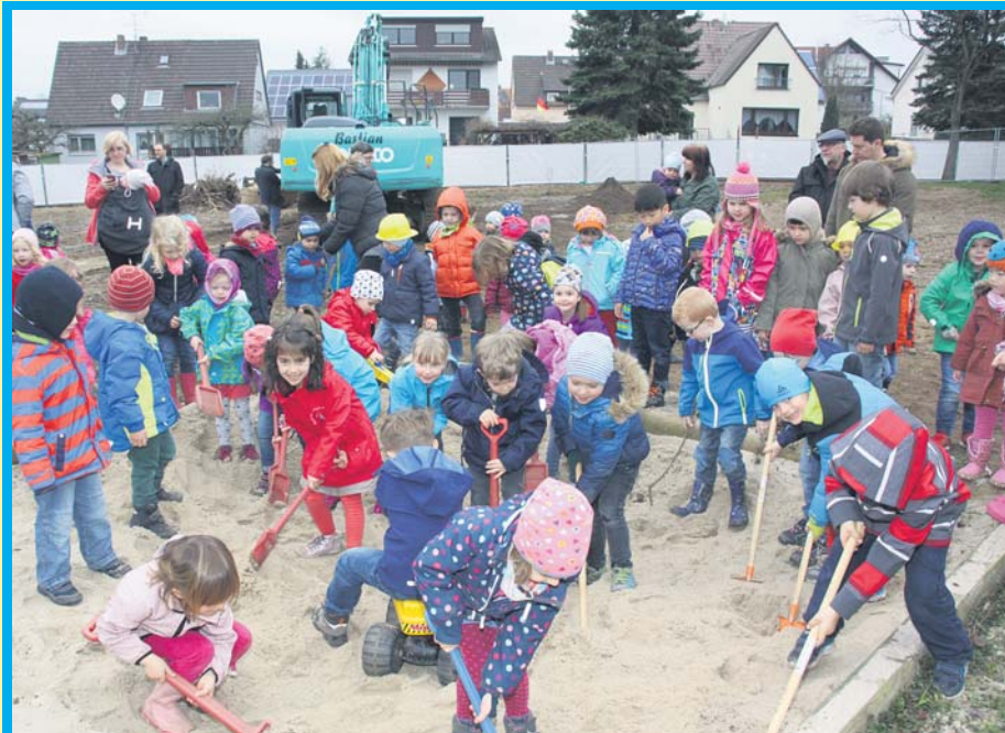
Die Kinder selbst machten am vergangenen Donnerstag mit großer Begeisterung die ersten Spatenstiche für den Neubau der Kita „Am Park“. In anderthalb Jahren soll die neue Einrichtung für 150 Kinder fertig sein. Foto: Schöffel
