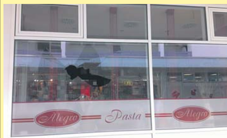
Die große Scheibe an der Pizzeria im Limes-Einkaufszentrum war nur eine von vielen Scheiben, die in der Nacht zum Donnerstag zu Bruch gingen. Auch ein Auto wurde zerstört. Foto: Baus
