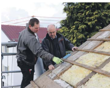
Wenn ein altes Dach mit einer schlanken Hochleistungsdämmung energetisch auf Vordermann gebracht wird, können alte Zwischensparrendämmungen drin bleiben. Foto: djd/puren
