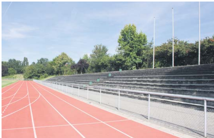
Ab Montag wird die alte Tribüne des Schwalbacher Limesstadions abgerissen.
