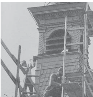
Das Türmchen an der „Alten Schule“ wurde vor 30 Jahren repariert ...
