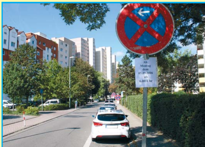
Bauarbeiten beginnen. Noch fließt der Verkehr in der Berliner Straße. Ab Montag wird ein neuer Kanal verlegt, so dass es bis Mitte Oktober zu Verkehrsbehinderungen auf einer der beiden Verbindungsstraßen zwischen Alt-Schwalbach und der Limesstadt kommen kann. Mehr dazu lesen Sie auf Seite 3. Foto: Schlosser
