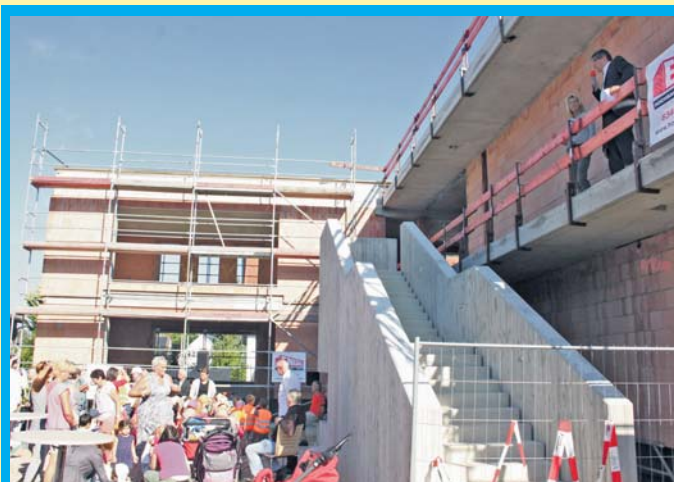
Vom Balkon des Neubaus aus erläuterte Architekt Thomas Zimmermann den Besuchern des Richtfestes das Gebäude. Bürgermeisterin Christiane Augsburg lobte die gute Arbeit von Architekten und Baufirmen. In einem Jahr soll alles fertig sein. Foto: Schlosser
