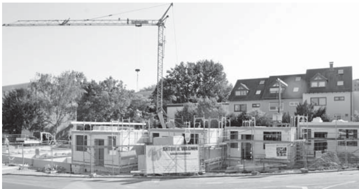
Baufortschritt. Vier der sieben Reihenhäuser, die am Ostring auf dem Gelände des ehemaligen Schlecker-Marktes entstehen, sind schon deutlich zu erkennen. Nach Jahren des Leerstands hatte die Stadt Schwalbach das Areal gekauft, ein städtebauliches Konzept erstellen lassen und das Grundstück dann an einen Investor weiterverkauft.
