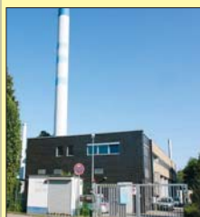
Das Grundstück, auf dem das Heizkraftwerk in der Adolf-Damaschke-Straße steht, gehört der Nassauischen Heimstätte. Die Stadt Schwalbach möchte es seit Jahren kaufen. Foto: Schlösser
