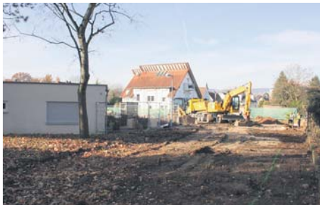
Wo einst ein Spielplatz war, soll ab dem Frühjahr Schwalbachs größte Kindertagesstätte entstehen. Die bisherige Kinderkrippe links wird ab der kommenden Woche abgerissen. Archivfoto: Schlosser
