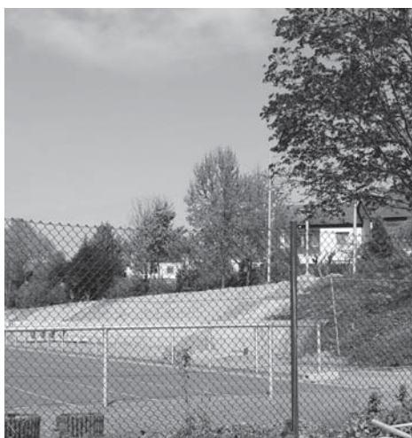
Zwischen dem Neubau der Tribüne des Limesstadions und den angrenzenden Einfamilienhäusern am Westring muss unter Umständen im kommenden Jahr eine rund 300.000 Euro teure Lärmschutzwand gebaut werden. Archivfoto:Schlosser
