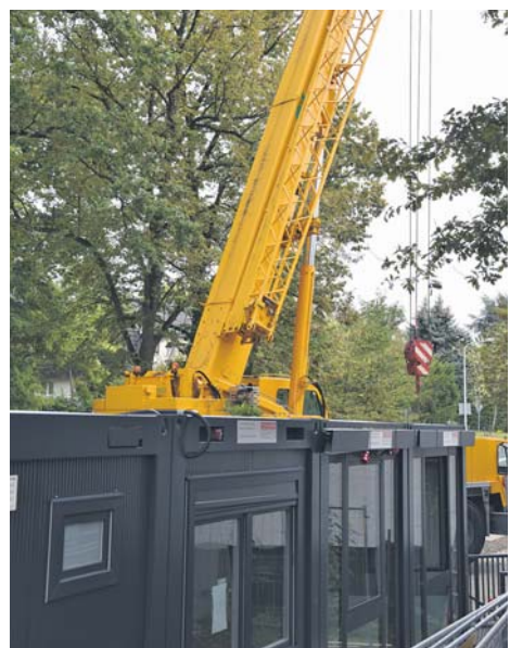
Container für Kinder. Ein großer Autokran stellte am Montag die Container für die provisorische Kinderkrippe neben die Geschwister-Scholl-Schule in Alt-Schwalbach. Untergebracht werden darin vorübergehend die Kinder der Krippe „Am Park“, die wegen des Neubaus der dortigen Kita abgerissen wird. Ein weiterer rund 40 Quadratmeter großer Container, der einen provisorischen Bewegungsraum enthält, wird am heutigen Mittwoch direkt auf dem Gelände der Kita „Am Park“ aufgestellt. Von 7 bis 17 Uhr ist die Straße daher heute gesperrt. Foto: Schiller
