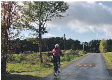
Die Straße „Am Sportplatz“ ist fertig saniert und auch die BMX-Strecke (links) wieder genutzt werden. Foto: mag
