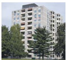
Wohnanlage in der Berliner Straße in Eschborn.
