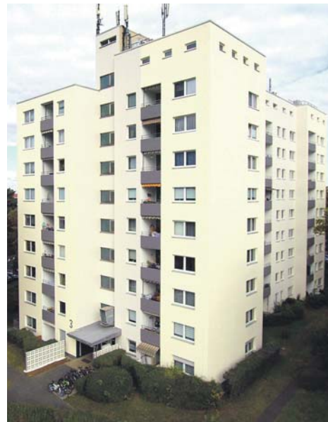
Wohnhaus in der Kurt-Schumacher-Straße in Eschborn.
