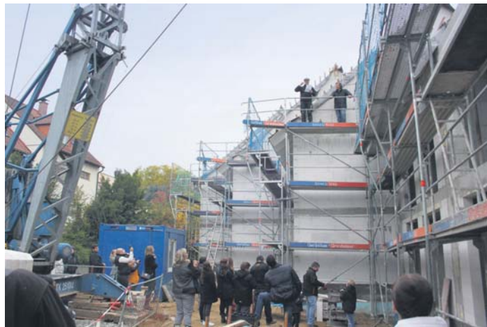
Richtfest. Mit Bier und Bratwurst feierten Bauarbeiter, Eigentümer und Nachbarn der sieben Reihenhäuser auf dem Areal des ehemaligen Schlecker-Marktes am Ostring am vergangenen Donnerstag Richtfest. Die jeweils rund 138 Quadratmeter großen Häuser, die in den vergangenen Wochen anstelle des lange verwaisten Komplexes gebaut wurden, sollen im März bezugsfertig sein. Foto: Schlosser
