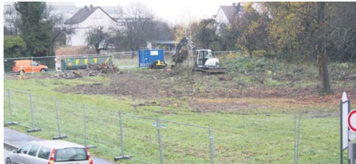
Der Bauzaun steht und ein Bagger gräbt auf dem Gelände „Im Wehlings“. Direkt an der Stadtgrenze zu Schwalbach entsteht ein Containerlager für bis zu 200 Flüchtlinge der Stadt Eschborn, das im März fertig sein soll. Foto: Schlosser
