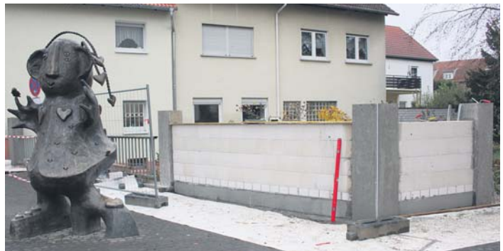
„Was soll das denn?“, fragen sich viele Schwalbacher. Bauarbeiter haben in den vergangenen Tagen an der alten Schule in der Schulstraße eine funktionslose Mauer errichtet. Foto: Schlosser
