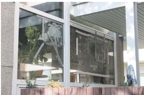
Erneut sind an der Bierstube am unteren Marktplatz Scheiben eingeworfen worden. Der Sachschaden ist hoch. Foto: Archiv
