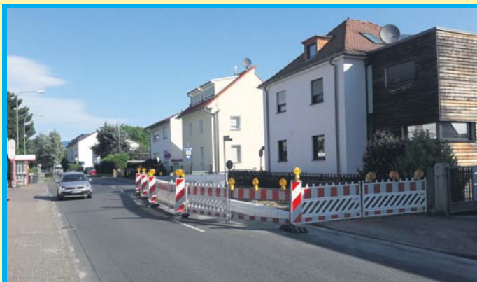
Einspurig läuft der Verkehr zurzeit in der Sulzbacher Straße auf Höhe der Sauererlenstraße. Die Stadt baut dort eine neue Bushaltestelle. Im Hintergrund ist auf der rechten Straßenseite der alte Haltepunkt nahe der Schulstraße zu sehen, der entfernt wird. Foto: Schlosser
