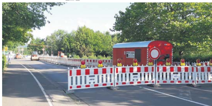
Während der Bauarbeiten an der Kreuzung ist die Zufahrt zur Sodener Straße gesperrt. Foto: Schlosser
