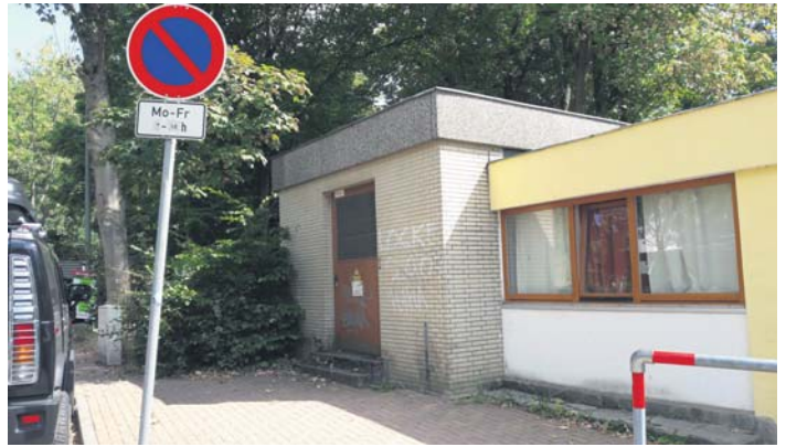
Ende August wird das alte Trafohäuschen neben der BDP-Stadtinsel abgerissen. Dort wird für 63.000 Euro eine vollautomatische, öffentliche Toilettenanlage installiert. Foto: Schlosser
