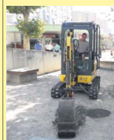
Am oberen Marktplatz wurde der am Montag der erste Graben für die neue Videoschutzanlage gezogen, die im Oktober fertig sein soll. Foto: Schlosser
