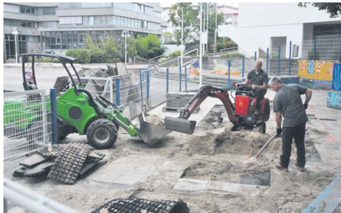
Mit zwei Baggern setzten Bauarbeiter den Spielplatz am unteren Marktplatz instand. Foto: mag
