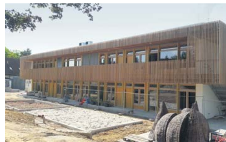
Eineinhalb Jahre nach dem ersten Spatenstich ist die neue Kita „Am Park“ fertig. Am Freitag ist Einweihung. Archivfoto: Schlosser
