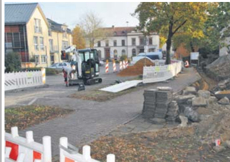
Der Energieversorger „Syna“ muss für einen neuen „Verteilerschrank“ an der Sackgasse zur Hardtbergstraße neue Stromleitungen in der Straße „Am Brater“ verlegen. Foto: mag
