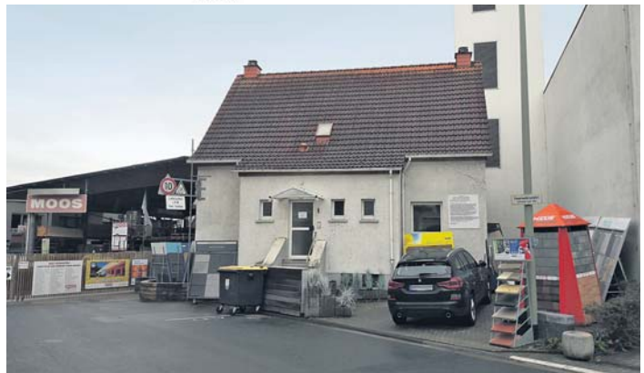
Das kleine Wohnhaus zwischen dem Feuerwehrhaus und dem Baustoffhandel Moos soll demnächst abgerissen und durch ein Wohn- und Geschäftshaus ersetzt werden. Nach einem Antrag der Grünen könnten dort vorübergehend Schulkinder betreut werden. Foto: Schlosser
