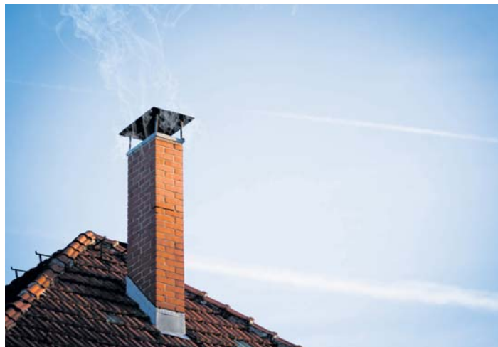
Unsanierete Altbauten sorgen für hohe Heizkosten und drücken auf die Klimabilanz. Ein Drittel aller Treibhausgase gehen laut Studien auf das Konto von Gebäuden. Die Industriegewerkschaft Bau-Agrar-Umwelt fordert mehr energetische Sanierungen auch im Main-Taunus-Kreis. Foto: IG BAU
