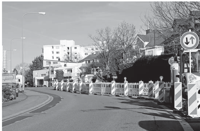
In der Berliner Straße wird zurzeit eine neue, barrierefreie Bushaltestelle gebaut.
