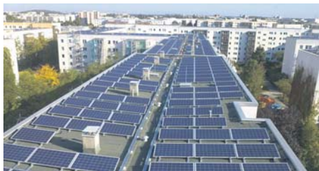
Die Flachdächer großer Wohnblöcke eignen sich ideal für Fotovoltaik-Anlagen, die Mieterstrom produzieren. Foto: Stadt & Land
