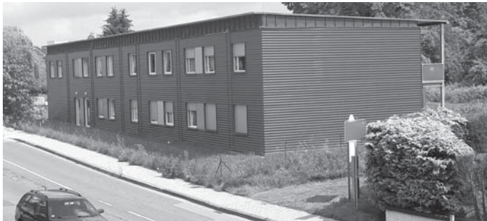
In dem Containerbau „Im Wehlings“ unmittelbar an der Stadtgrenze zu Schwalbach werden zukünftig anerkannte Asylbewerber und Obdachlose untergebracht.
