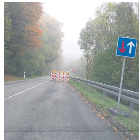
Die Straße durch den Schwalbacher Wald ist zurzeit auf einem kurzen Stück nahe dem Schafhof halbseitig gesperrt. Foto: mag
