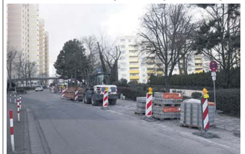
In der Berliner Straße werden zurzeit die Gehwege saniert. Foto: Schlosser
