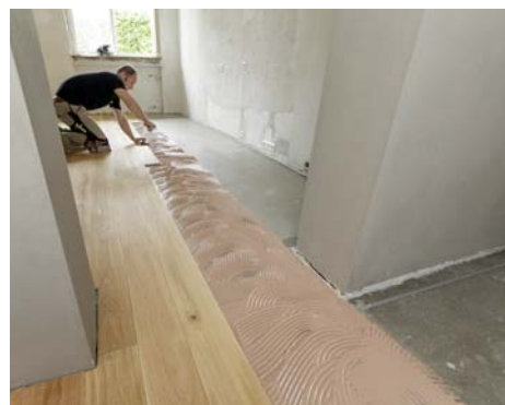
Alte Steinfliesen bilden einen guten Untergrund für einen neuen Parkettboden. Sie müssen nur richtig vorbehandelt werden. Foto: pik
