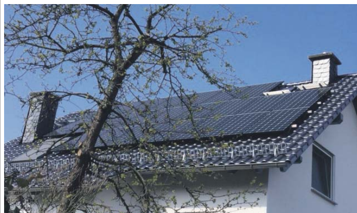
Eine Photovoltaik-Anlage spart Stromkosten.
