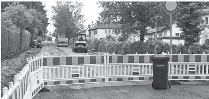
Baustelle und Umleitung. In der vergangenen Woche hat die Sanierung der Eschborner Straße begonnen. Dort werden der Gehweg und die Asphaltdecke erneuert. Außerdem werden die beiden Bushaltestellen barrierefrei umgebaut. Bis voraussichtlich 7. August ist die Ausfallstraße in Richtung Eschborn gesperrt. Die Umleitung erfolgt über die Bahnstraße und die Frankfurter Straße in Richtung Eschborn beziehungsweise über die Niederräder Straße in Richtung Schnellstraße. Foto: Schlosser
