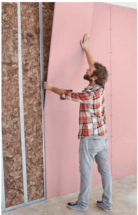
Zuerst wird die Unterkonstruktion montiert, darauf kann der Heimwerker dann die passend zugeschnittenen Gipsplatten befestigen und anschließend tapezieren. Foto: djd/Knauf Bauprodukte
