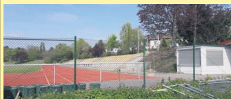
2016 wurde die alte Tribüne im Limesstadion abgerissen. Weil das Verwaltungsgericht den Bebauungsplan für ungültig erklärt hat, konnte mit dem Neubau bisher nicht begonnen werden. Archivfoto: Schlosser
