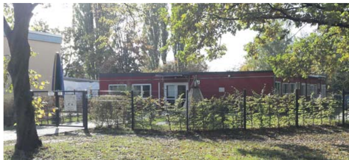
Rund 1,8 Millionen Euro stehen im Entwurf des Haushalts für 2021 für den Neubau der DRK-Kita „Schwalbennest“ am Mittelweg, die bisher in Containern untergebracht ist. Archivfoto: Schlosser
