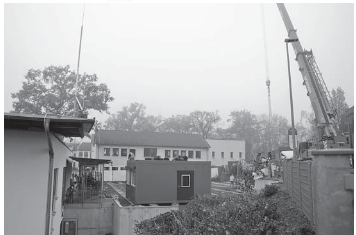
Die Container des Interim-Schulkinderhauses III an der Geschwister-Scholl-Schule werden neben dem Gebäude C der Alt-Schwalbacher Grundschule aufgebaut. Anfang 2021 soll alles fertig sein. Foto: mag
