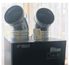
So sieht ein Luftfilter mit Kohlendioxid-Ampel aus, wie er in Schulen im Main-Taunus-Kreis zum Einsatz kommt. Foto: MTK
