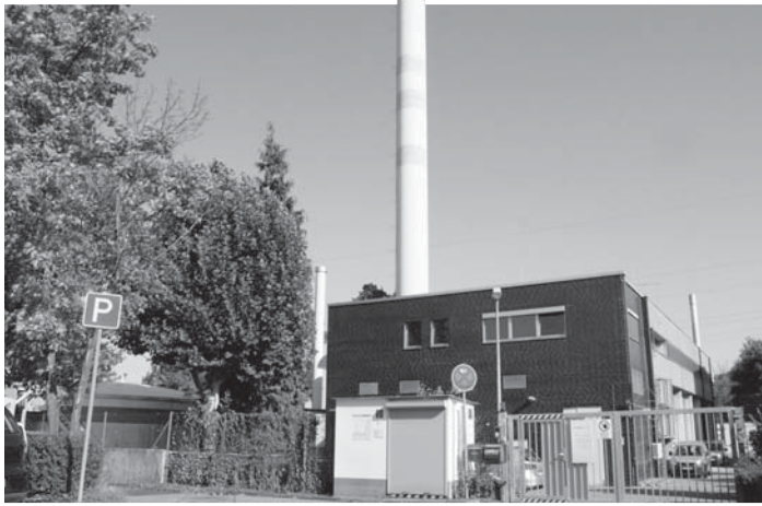
Das Heizkraftwerk in der Adolf-Damaschke-Straße.
