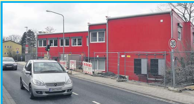
Neues Schulkinderhaus. Ende März sollen die ersten Grundschüler in das Schulkinderhaus III einziehen, das in den vergangenen Monaten auf dem Schulhof der Geschwister-Scholl-Schule entstanden ist. Der Bau war Maßarbeit: An der engsten Stelle steht das neue Gebäude nur 30 Zentimeter vom Bürgersteig entfernt. Mehr dazu lesen Sie auf Seite 5. Foto: Schlosser
