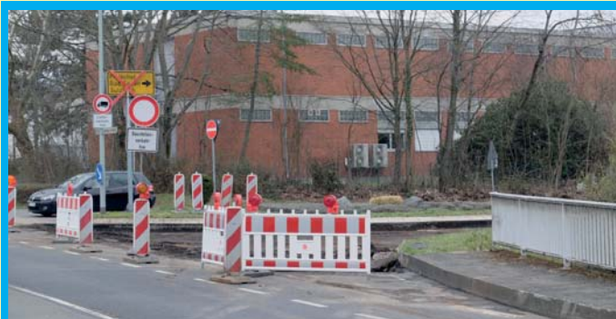
Brückensanierung an der Limespange. Seit Montag sind an Ost- und Westring zwei Auf- und Abfahrten zur Limespange gesperrt. Bis Mitte Mai werden die Bauarbeiten voraussichtlich anhalten. Entsprechende Umleitungen sind über die Avrilléstraße eingerichtet. Die Sanierungen sind eine von fünf weiteren Baustellen, die laut „Hessen mobil“ entlang der Limespange erfolgen werden. Weiterhin werden im April an den ersten drei Wochenenden der West- und Osttring in Richtung Marktplatz halbseitig gesperrt. Foto: Brehm
