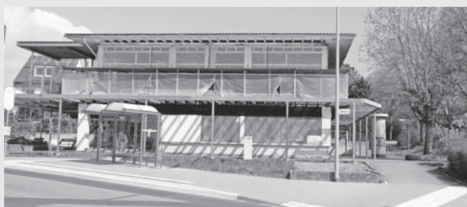
Ein gewisser Baufortschritt ist am Gebäude des ehemaligen Lebensmittelladens am Westring 2a nach zehn Jahren Bauzeit zu erkennen. 2011 begannen die Bauarbeiten. Foto: Brehm
