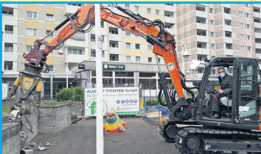
Mit einem Bagger riss Bürgermeister Alexander Immisch die ersten Teile einer Mauer ab und gab damit den Startschuss für die Umgestaltung des unteren Marktplatzes. Im Februar 2022 sollen die Bauarbeiten abgeschlossen sein. Foto: Schlosser
