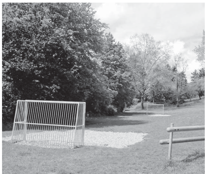
Der Bolzplatz an der Eichendorffanlage wurde mit zwei neuen Toren und einer Sitzmöglichkeit rundum erneuert. Vor den Toren gibt es jetzt auch einen Fallschutz. Foto: mag
